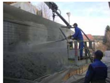
Die Sanierungsarbeiten der Mauer wurden bereits abgeschlossen. Mit 5 Meter langen Erdankern, welche mittels Betoninjektion mit dem umliegenden Erdreich verbunden wurde, sowie in weiterer Folge einer doppelten Eisenmattenverlegung und 15 cm Spritzbeton im Bereich der Mauer, wurde die Statik der Zufahrtsstraße wieder sichergestellt.
