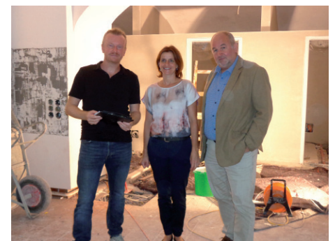
Die Adaptierungsarbeiten bei der Ordination gehen zügig voran. Architekt DI Axel Kos, Dr. Ute Müllner und Bgm. Hannes Kogler beim Baustellenbesuch.
